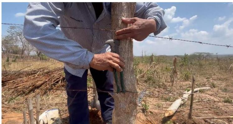
Figura 2b: los hilos de alambre como rectas paralelas; dos dedos, una cotorra como patrón de medida
